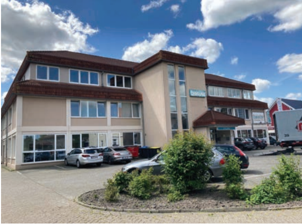
Das Gebäude an der Leerer Landstraße
