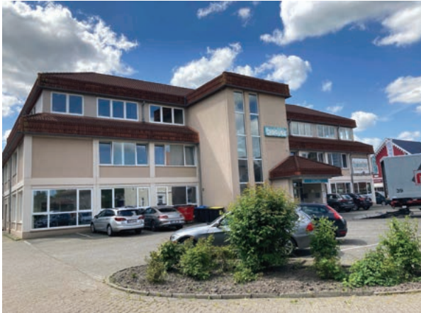
Das Gebäude an der Leerer Landstraße
