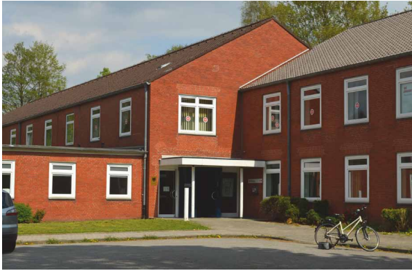
Das Gebäude in der Skagerrakstraße
