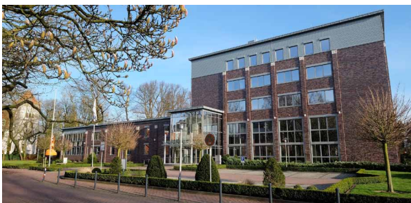
Das Gebäude der BAV am Hauptsitz Aurich
