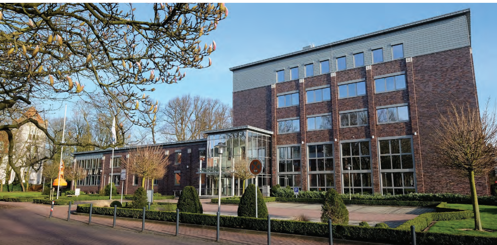
Das Gebäude der BAV am Hauptsitz Aurich
