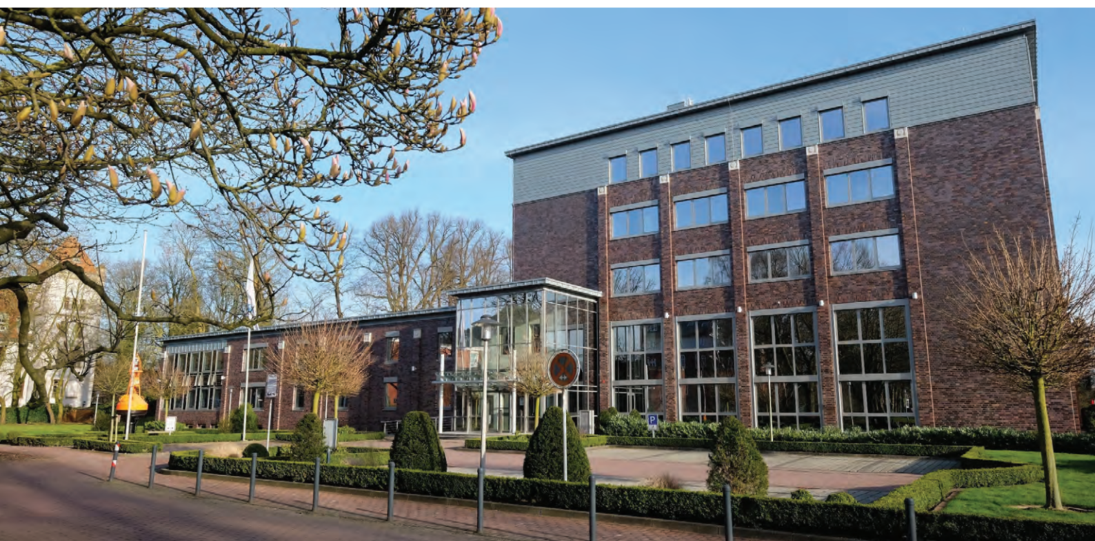
Das Gebäude der BAV am Hauptsitz Aurich
